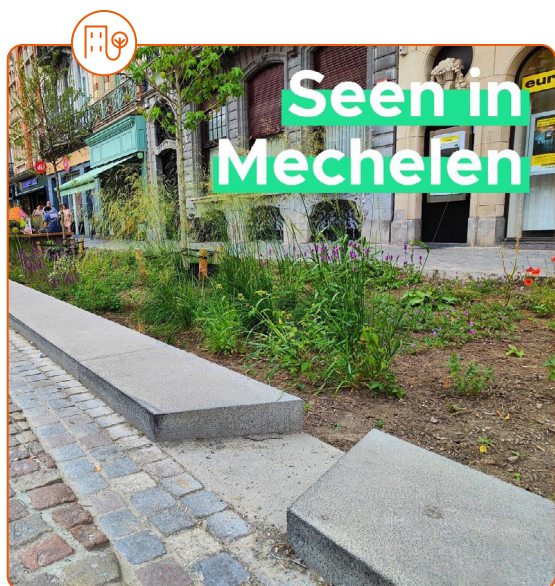
Alternatieve aanleg voor riolering, centrum van Mechelen (Canal it up, 2023)
